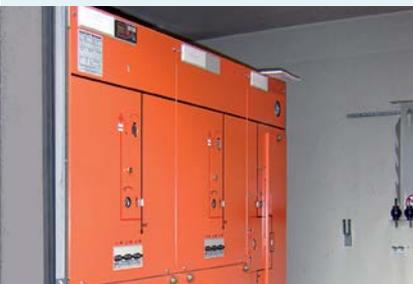
Anordnung der SF<sub>6</sub>-isolierten Schaltanlage nach dem Umbau
