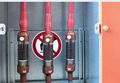
Ölgefüllte Sichtendverschlüsse nach dem Umbau
