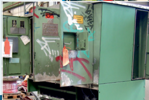
Stationssanierung, z.B. Lahmeyer-Station
